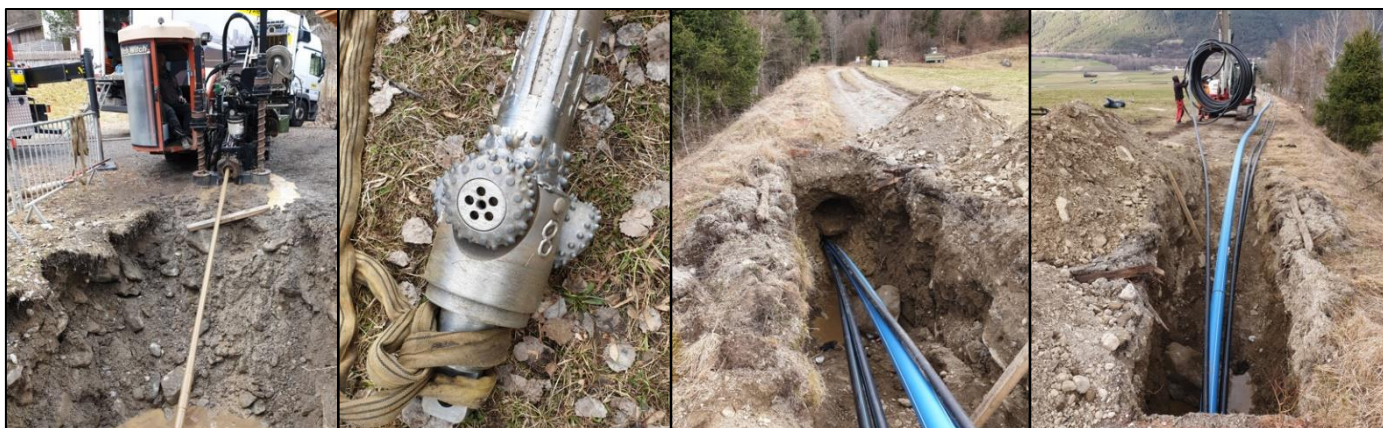
Die gelenkte Bohrung unter dem Kanzingbachgerinne ausgeführt von der RBS Bau.
